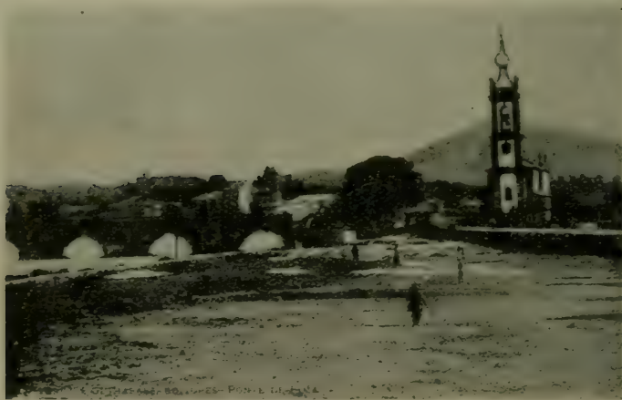
Alem da Ponte. — Margem direita
